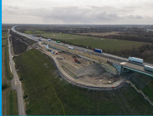
Südseite Vorbereitung Widerlager und Taktchiebung
